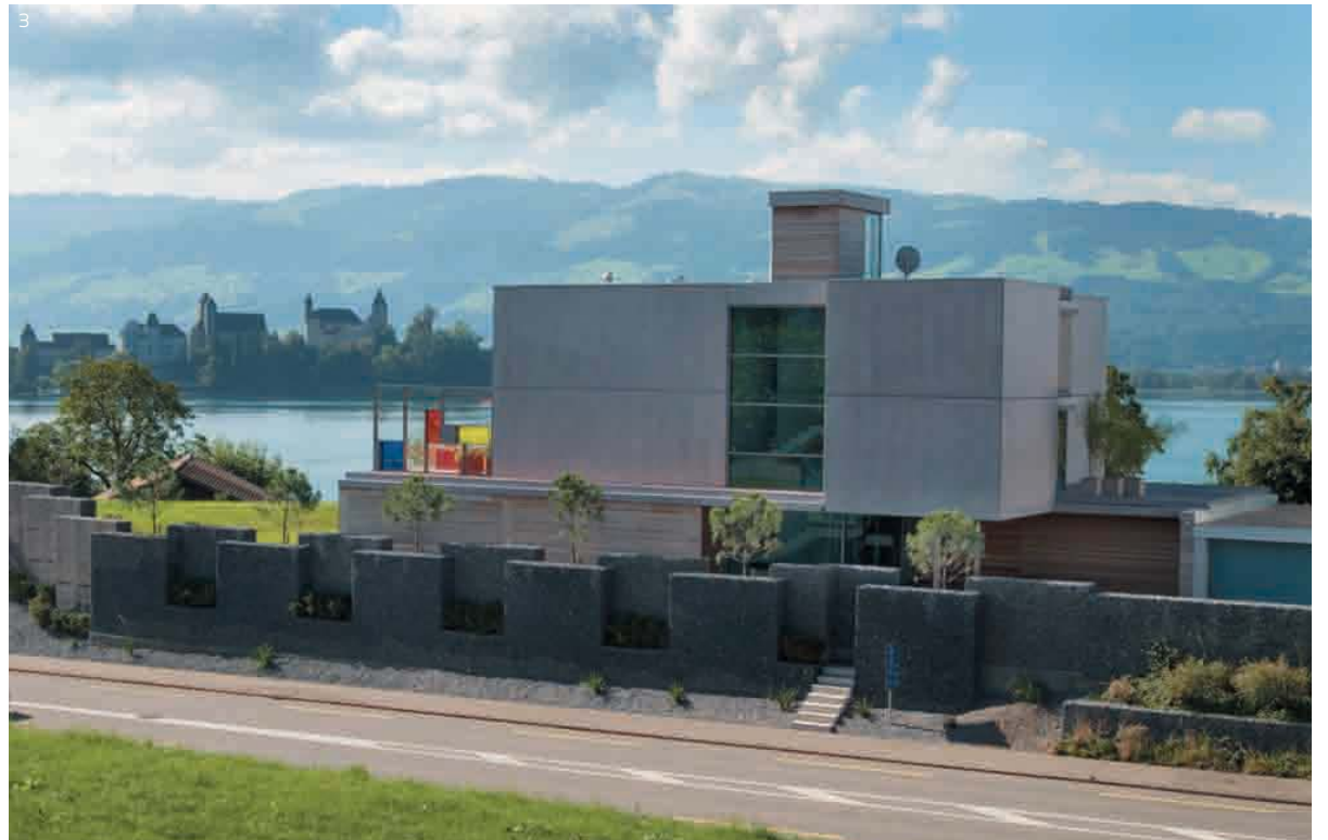
1_ Die Garage des Erdgeschosses definiert auf der östlichen Stirnseite die Terrasse des ersten Obergeschosses. Die gläserne Lärmschutzwand mit roten, gelben und blauen Transparentflächen versteht sich auch als Kunst am Bau. 2_ Das grosse Volumen öffnet sich an der Südseite auf die unverbaubare Landschaft. 3_ Das Haus ist nach Norden zur Erschliessungsstrasse durch versetzte Steinkörbe abgeschirmt.
